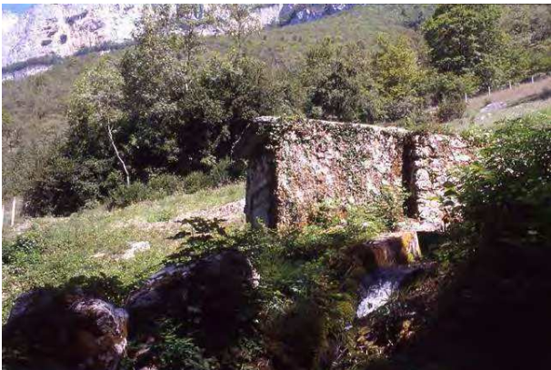
Captage de Laval
